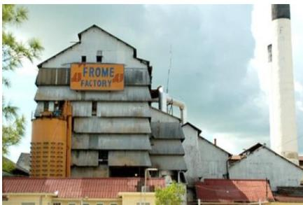
C'est la centrale biomasse la plus importante des 7 de la Jamaïque, et de nombreux tests sur différents combustibles biomasse y ont été effectués. Les données de 2011 indiquaient une capacité de 29 MWe en cogénération utilisant de la bagasse (313 000 t/an) et du bois (97 100 t/an), à une pression chaudière de 65 bars.
